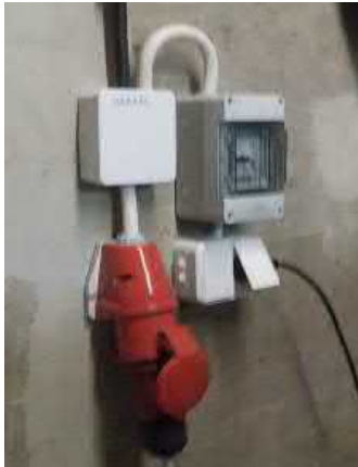
Pistorasioita ja niiden haaroituskotelo
