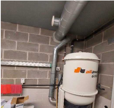
Keskuspölynimurijärjestelmän keskusyksikkö.
