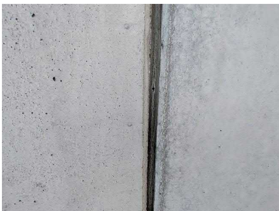
Elementtisaumat ovat käyttöikänsä päässä
