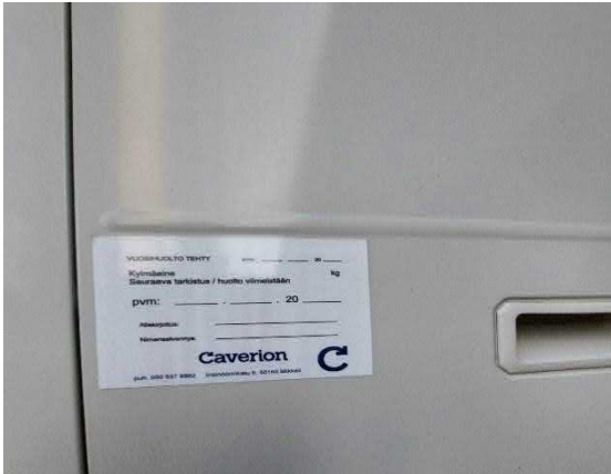
Tarkastus/huoltotarraan ei ole merkitty edellisen huollon ajankohtaa.
