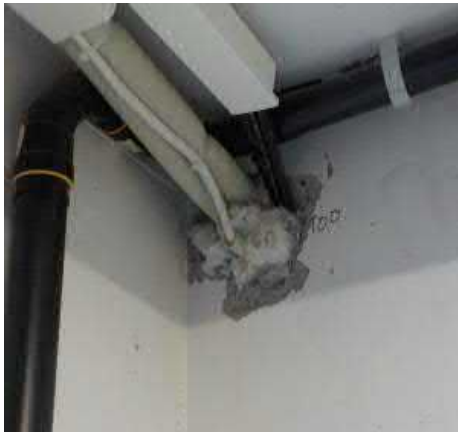
Kaapelien läpivientiä seinässä
