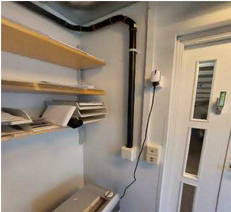
Keskuspölynimurijärjestelmän imurasia.
