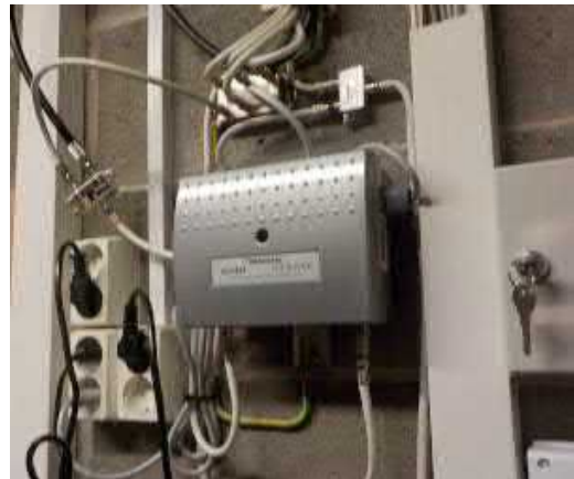
Antennivahvistin ja -jaottimia teletilassa
