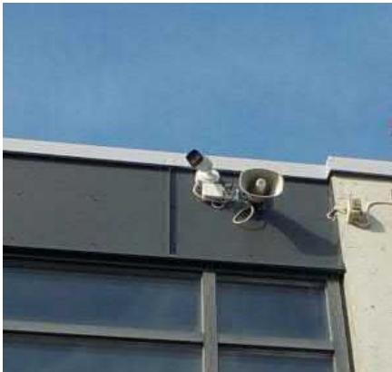
Valvontakamera ulkoseinällä
