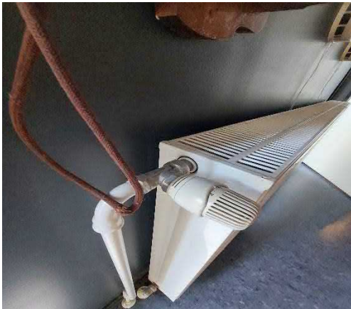
Patteriventtiili ja termostaatti.
