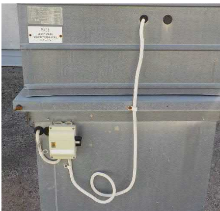
Huippuimurin sähköistystä vesikatolla
