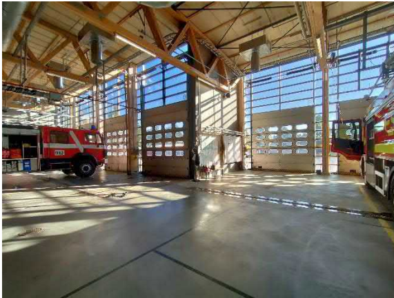
Kalustohallin alapohjassa ei havaittu halkeamia
