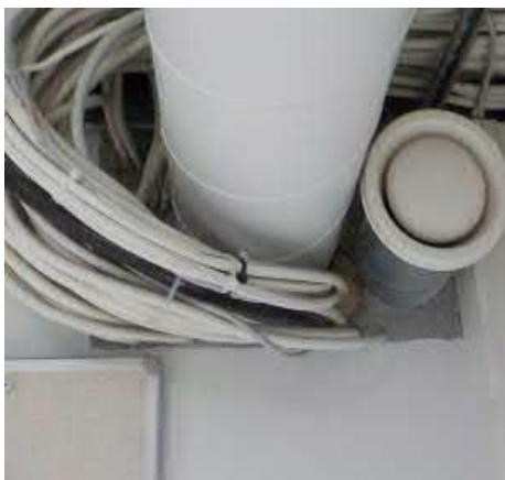
Kaapelien läpivientiä IV-kanavan vieressä
