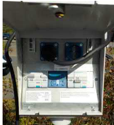
Ajoneuvon lämmityksen ja latauksen mahdollistava kotelo
