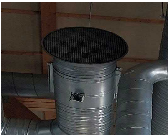
Poistoilma-imukartio autohallissa.
