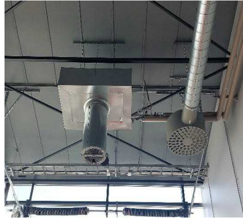
Autohallin kiertoilmapuhallin.
