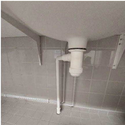
Alkuperäinen pesualtaan vesilukko.
