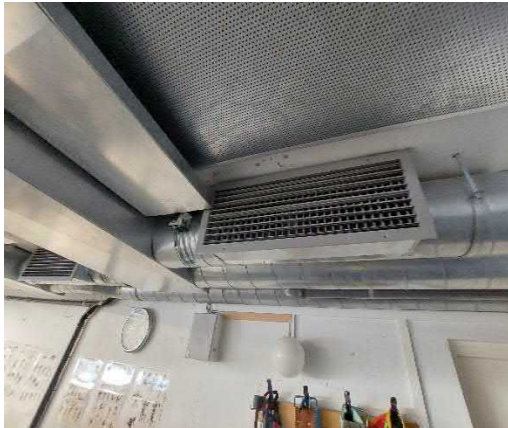
Poistoilmasäleikkö kuntosalitiloissa.
