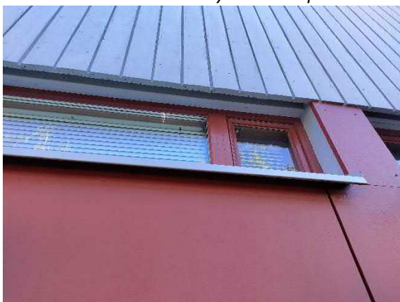
Sisäpihan puolen julkisivuissa levytys
