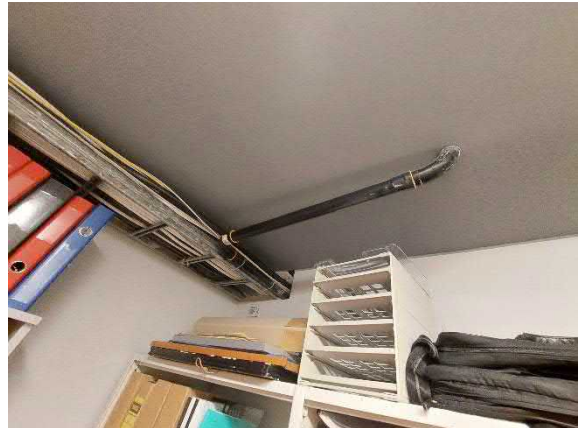
Keskuspölynimurijärjestelmän imuputkistoa.
