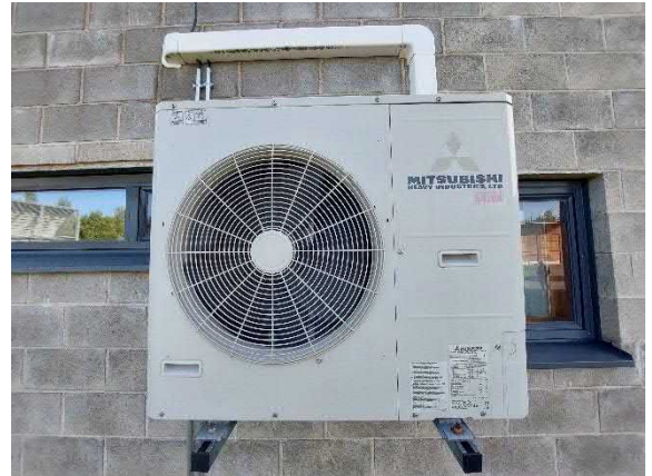
Jäähdytysjärjestelmän ulkoyksikkö.
