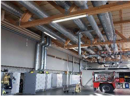
Kalustohallin ilmanvaihtokanavistoa.
