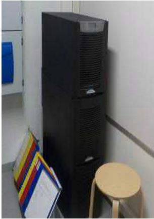
UPS-laitteistoa väestönsuojassa
