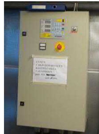
Varavoimalaitteiston ohjauskeskus
