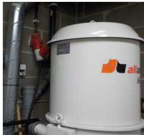
Keskuspölyimurin sähköistystä varastossa
