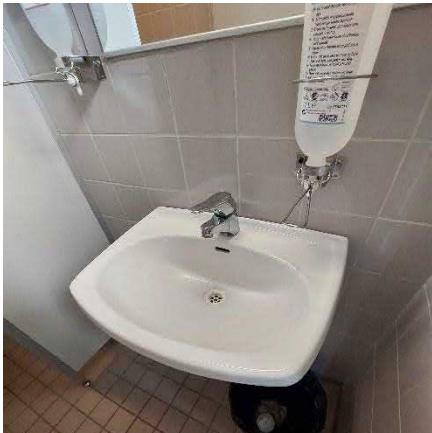
Alkuperäinen pesuallas ja pesuallashana.
