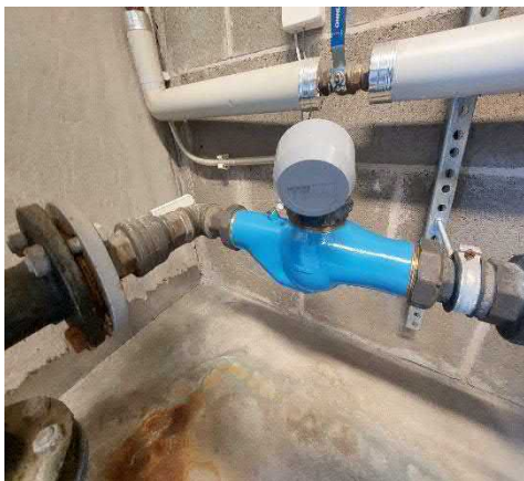
Kiinteistön päävesimittari.
