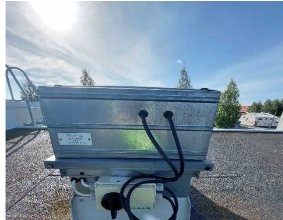
TK03PF02 poistoilmahuippuimuri.
