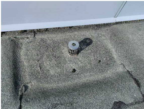
Kattokaivot ovat puhtaita
