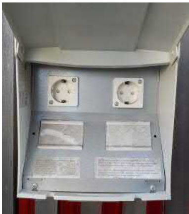
Pelastusajoneuvon sähköistykseen tarkoitettu kotelo ilman ohjauksia
