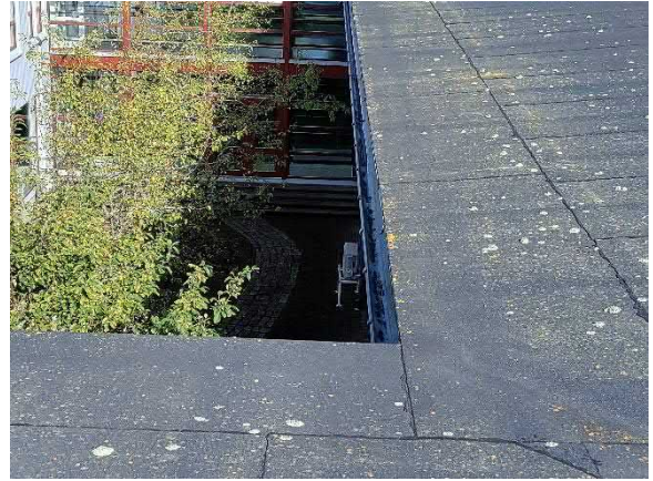
Sadevesikourut ovat siistit ja roskattomat
