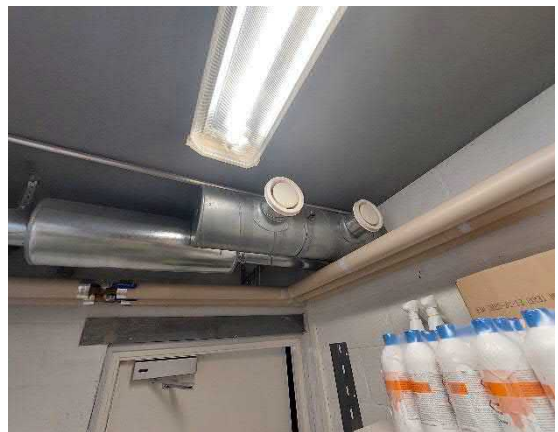
Poistoilmaventtiilit varastossa.
