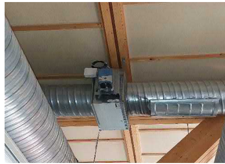
Toimilaitteella varustettu sulkupelti.
