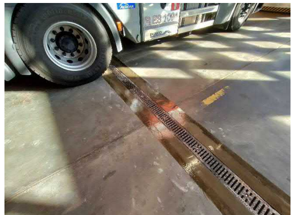
Hallin lattia on osittain uusittu
