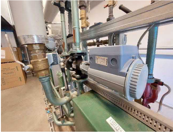
Uusittu säätöventtiili ja toimilaite.
